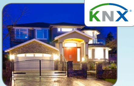
sistemi di automazione
